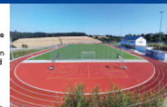
SG-Karlsruhe Sportanlage © Jens Pöcher
